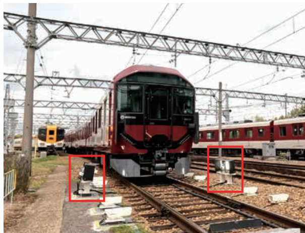
検査線に設置された車両床下検査システム（西大寺車庫）
