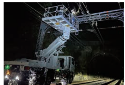
④軌陸車による架線検査（夜間作業）
