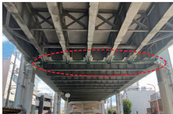
橋梁落橋防止工事（ブラケット設置工）
