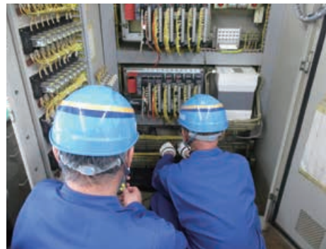
② 制御器の検査
