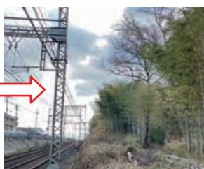
伐採後（五位堂駅～築山駅間）
