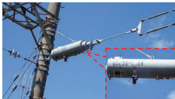
テンションバランサー監視装置
