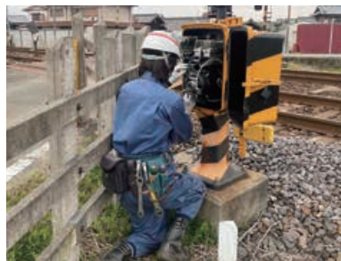
②踏切保安装置検査（遮断機）
