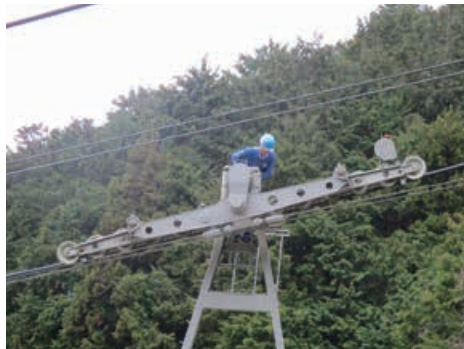
① 支索（ロープ）の検査
