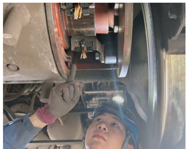
④主電動機の検査
