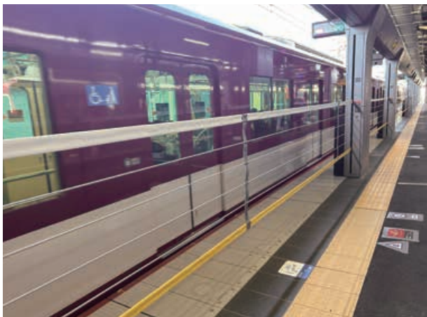
鶴橋駅1番線ホーム(昇降ロープ式ホームドア)
