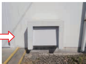
対策後（北楠変電所）
