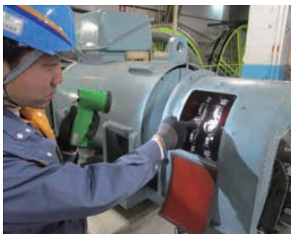
②けん引用ケーブル・巻上電動機の検査
