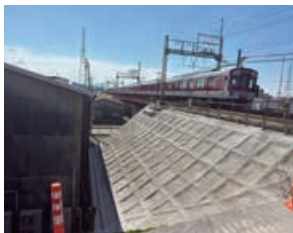
法面補強（矢田駅～河内天美駅間）
