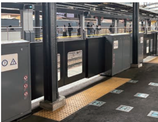
鶴橋駅3番線ホーム(大開口ホーム柵)
