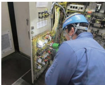
③けん引用ケーブル・巻上装置制御器の検査
