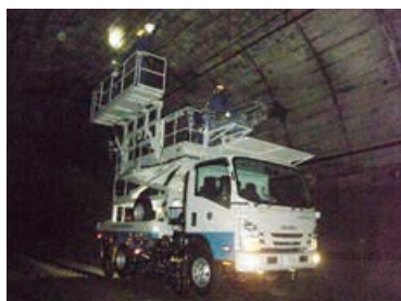
トンネル検査
