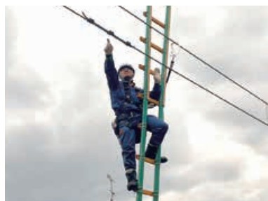
④架線点検
