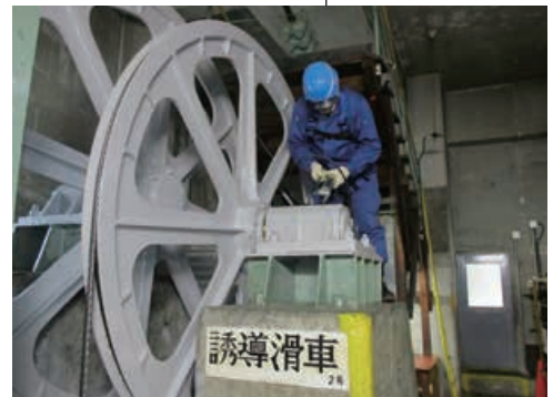
③ 誘導滑車の検査
