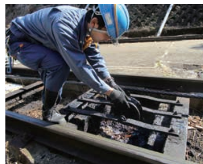
①けん引用ケーブル・誘導滑車の検査
