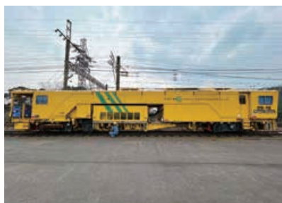
線路の補修作業 (つき固め作業※・マルチプルタイタンパー)
