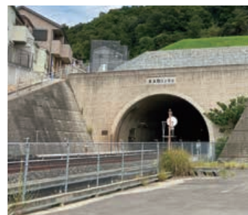
対策工事完了
