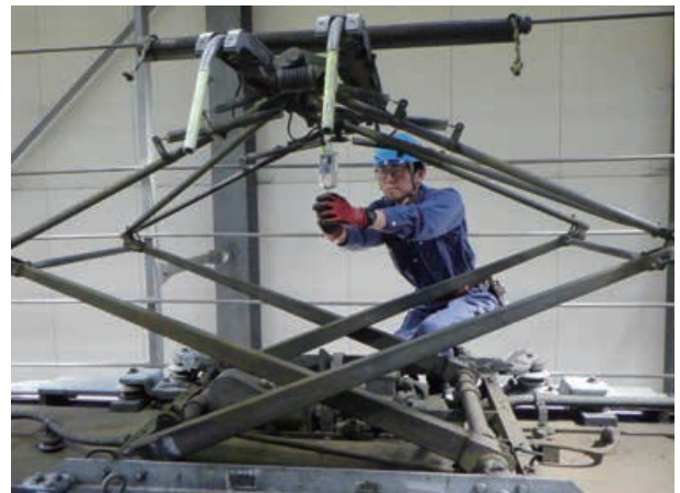
②パンタグラフの検査
