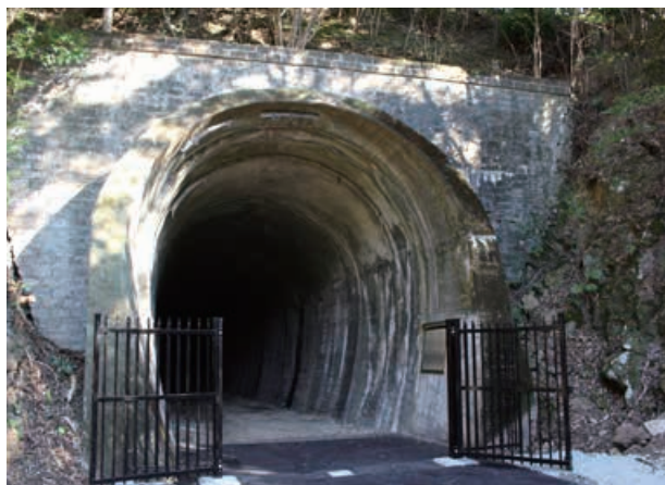
現在の（旧）総谷トンネル
